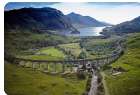
格蘭芬南鐵路高架橋
