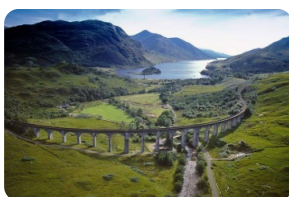
格兰芬南铁路高架桥
