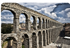
古罗马大渡槽
