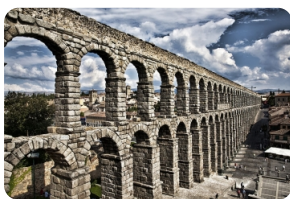
古罗马大渡槽
