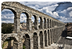
古罗马大渡槽
