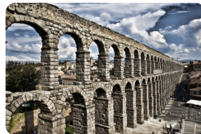
古罗马大渡槽
