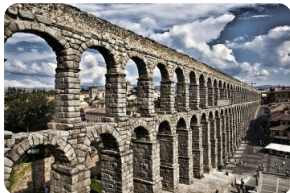
古罗马大渡槽
