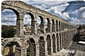
古罗马大渡槽
