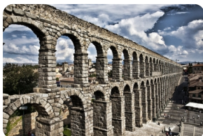
古罗马大渡槽
