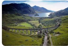
格兰芬南铁路高架桥
