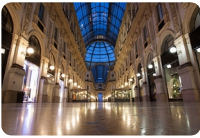
埃马努埃莱二世拱廊桥
